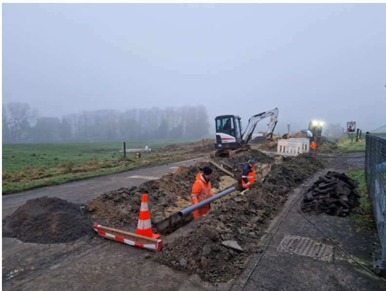
Pose de la conduite de sécurisation à hauteur du village d'Abée
