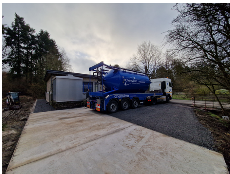
Mise en place du filtre à charbon actif
